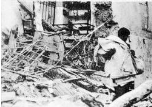
Destrozos Las bombas causaron numerosos daños.
